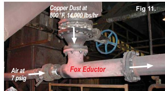
再也没有比 FOX 文丘里喷射器更可靠的方法来输送来自干燥炉，反应器或煅烧炉的高温矿石，水泥，烟灰等。
