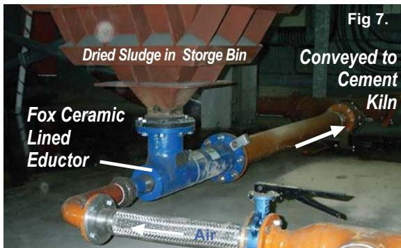
FOX 文丘里喷射器输送干淤泥至一水泥炉（英国，0.8bar 空气）。
