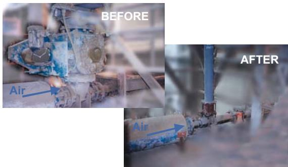
FOX 文丘里喷射器常常被用于替换旋转锁气阀，消除回气及额外电机，提供更可靠的输送系统。
